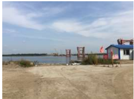
写真6 兩岸から進む橋の建設
