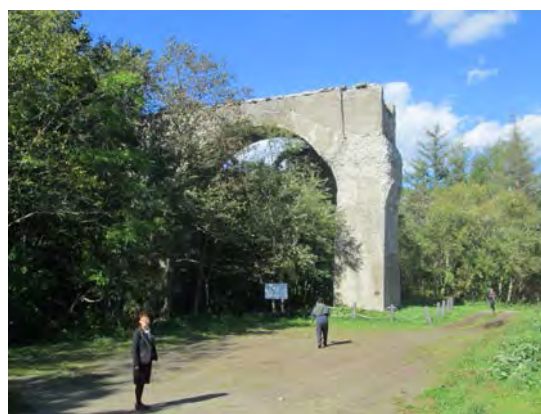
コンクリートアーチ
